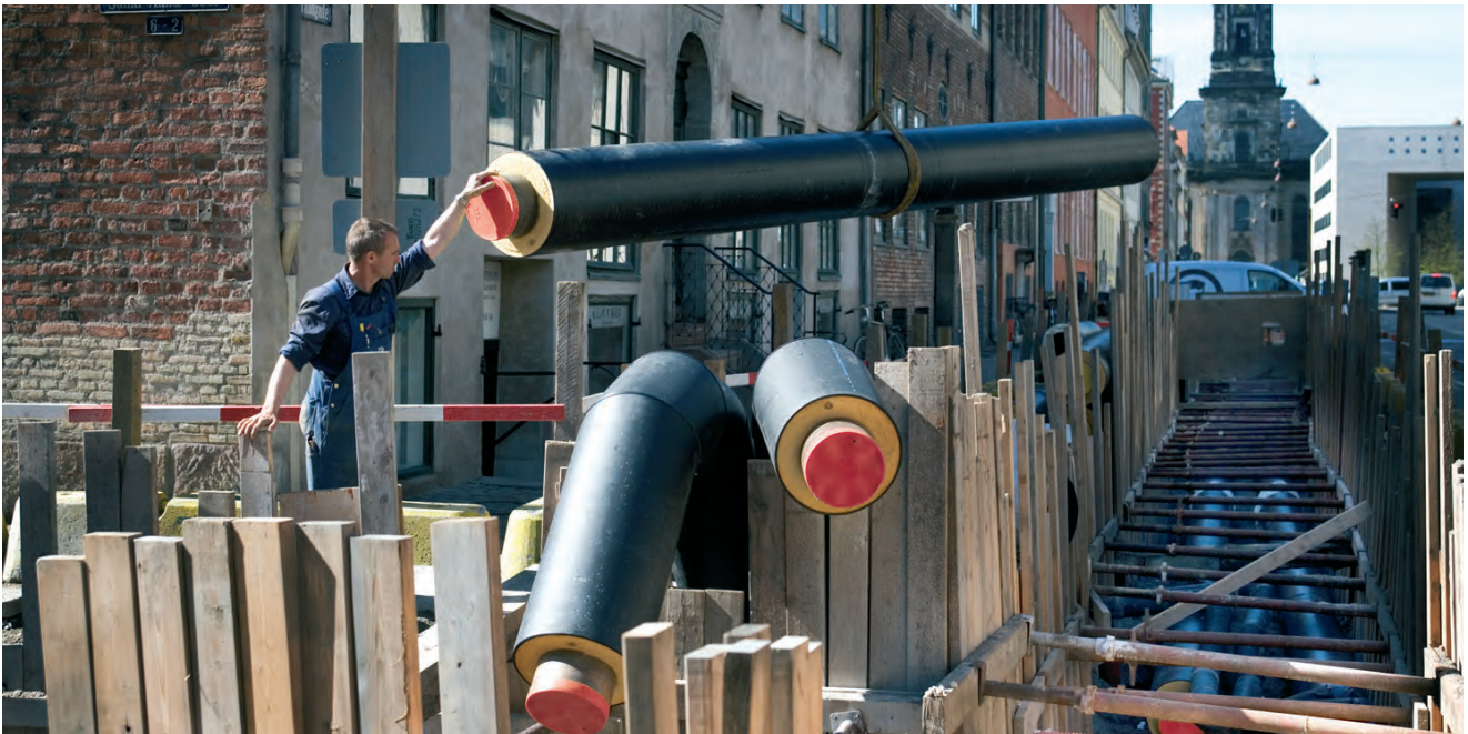
图10：哥本哈根市安装新区域供热管道
