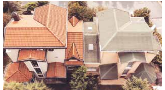
Kil Esaslı Çatı Kaplama Malzemesi Uygulaması / Shingle Uygulaması
